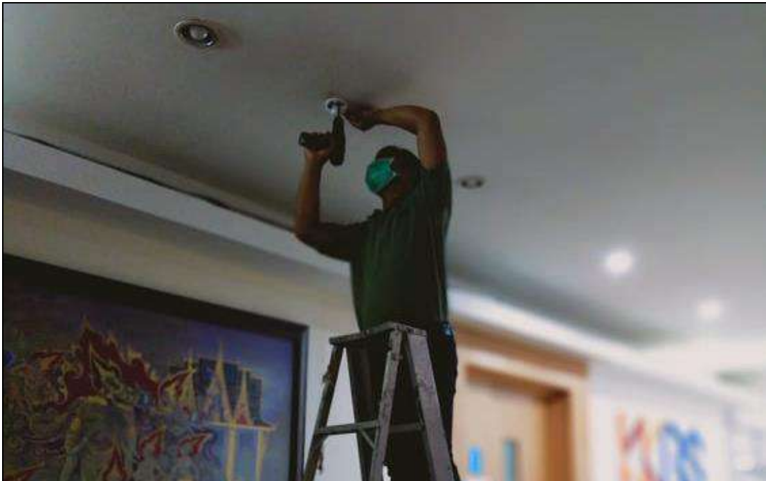
ภาพที่ 79 แสดงการซ่อมเปลี่ยน Sensor เปิด-ปิดไฟอัตโนมัติ
