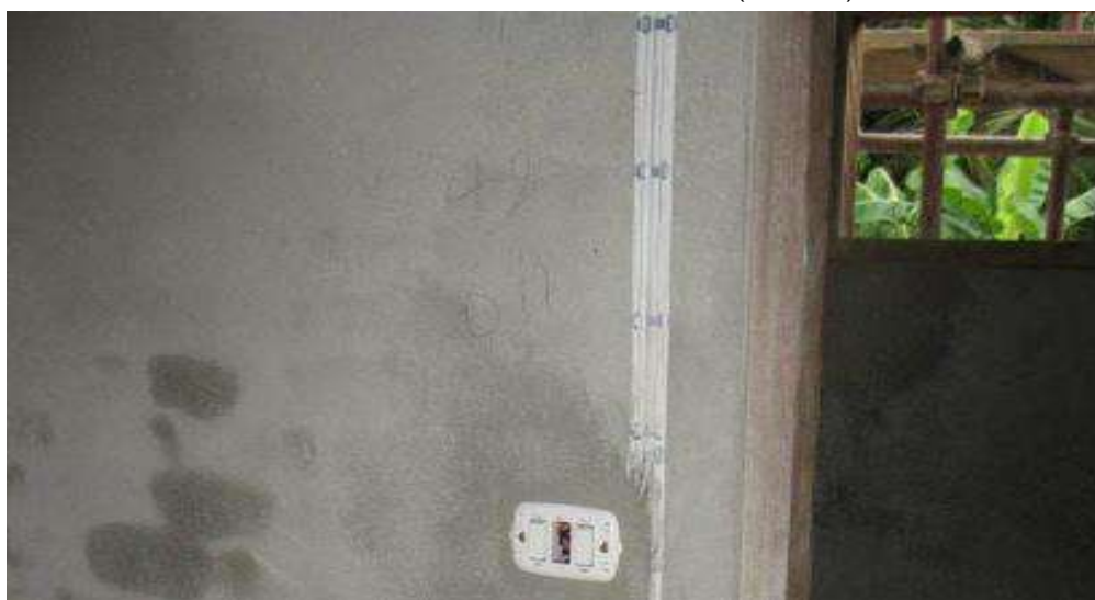
ภาพที่ 6 แสดงการเดินสายไฟแบบเปิด (เดินลอย)
