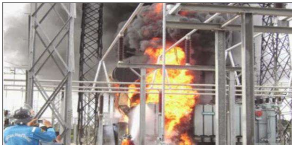
ภาพที่ 45 แสดงการระเบิดของหม้อแปลงไฟฟ้า
