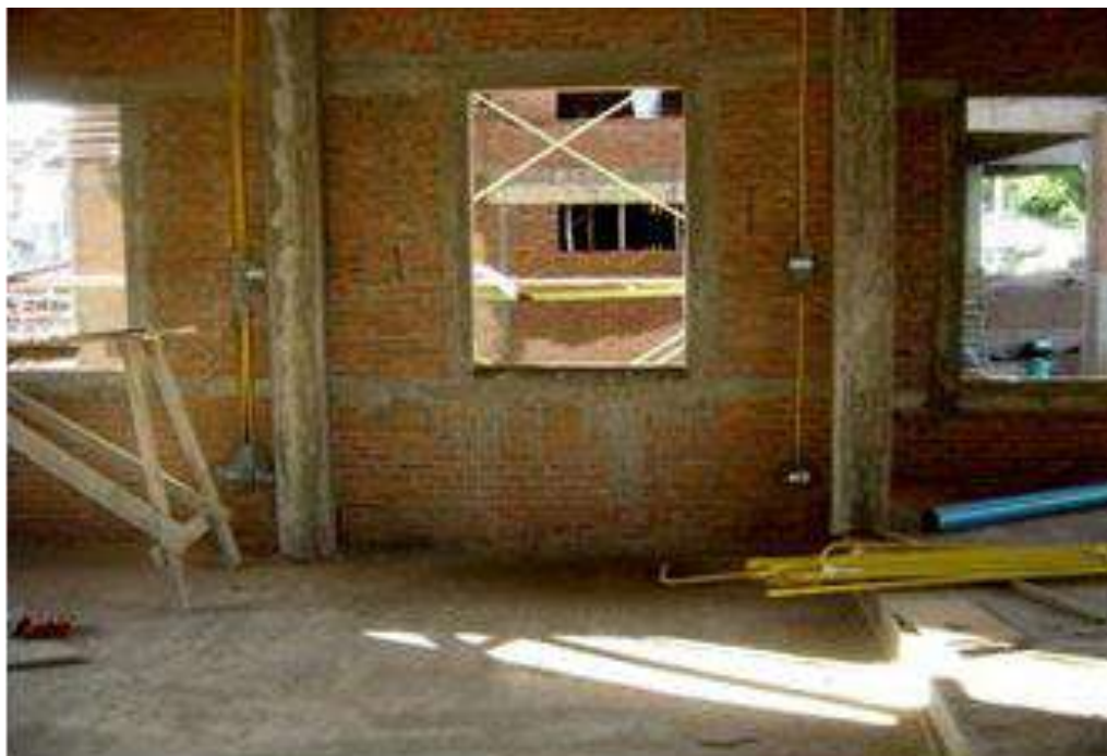
ภาพที่ 7 แสดงการเดินสายไฟแบบปิด
