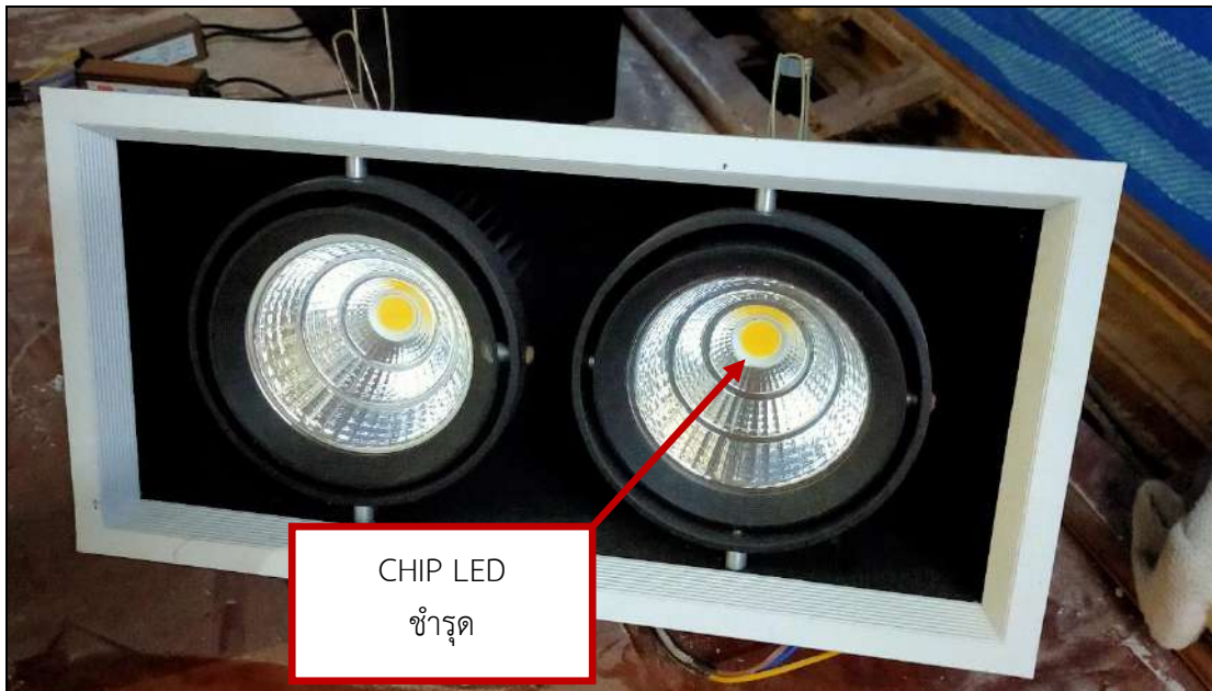
ภาพที่ 63 แสดงการสำรวจความเสียหายในเขตพื้นที่จริง ( Chip LED ชำรุด)
